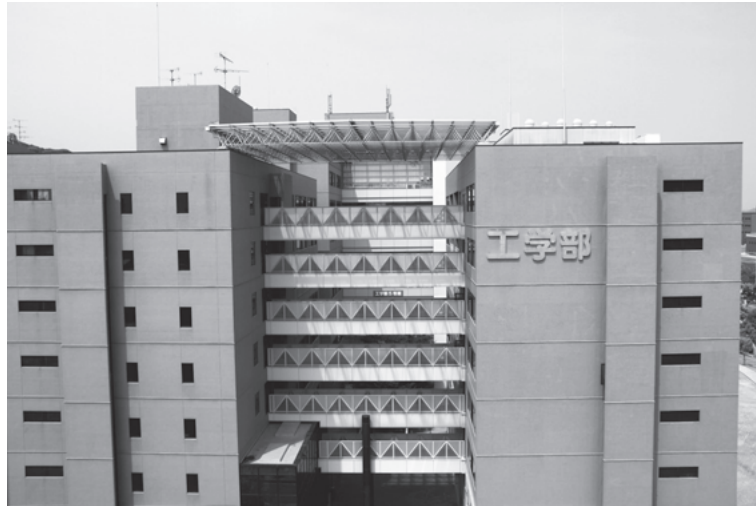
現在の工学部本館（左）と1号館（右） 中央奥が5号館
