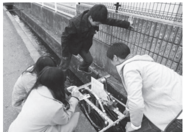
図1 水力発電装置を設置する学生
