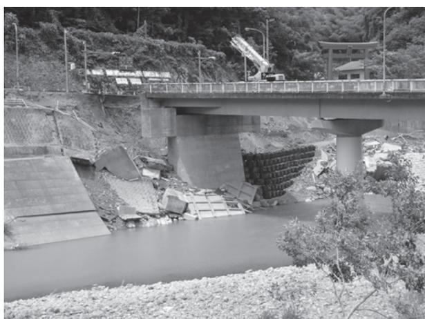
肱川氾濫による護岸崩壊と橋台の露出
